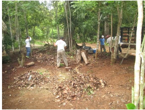
Limpieza del camino forestal principal para ingresar al área comunitaria de conservación
